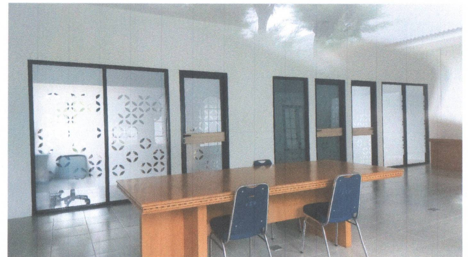
Hasil Akhir Pekerjaan
