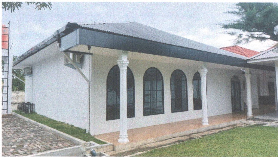
Hasil Akhir Pekerjaan
