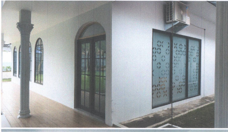
Hasil Akhir Pekerjaan
