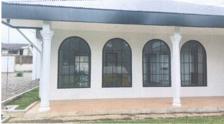
Hasil Akhir Pekerjaan
