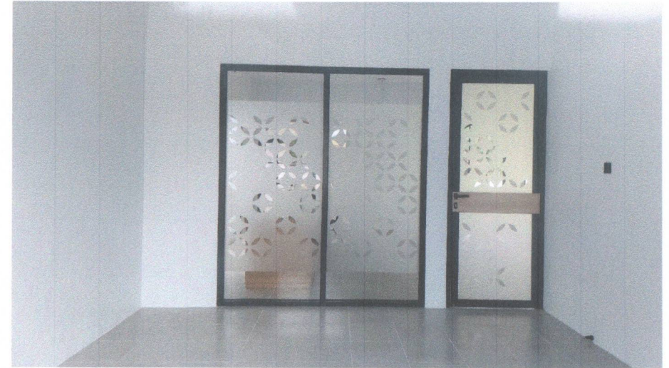
Hasil Akhir Pekerjaan
